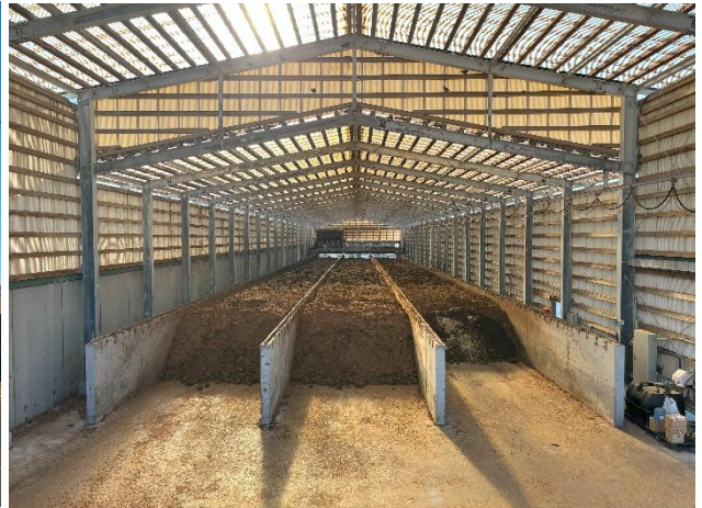
画像 1 1 堆肥舎内観
