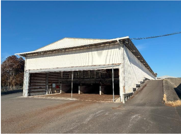
画像 1 0 堆肥舎外観
