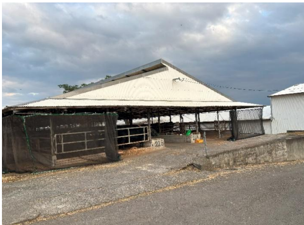
画像 10 22号舎外観
