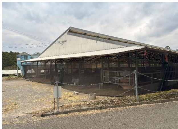
画像 11 21号舎外観
