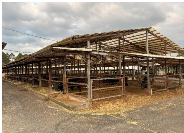
画像 8 7号舎外観
