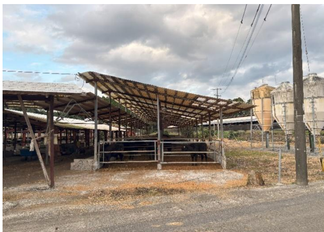
画像 7 3号舎外観
