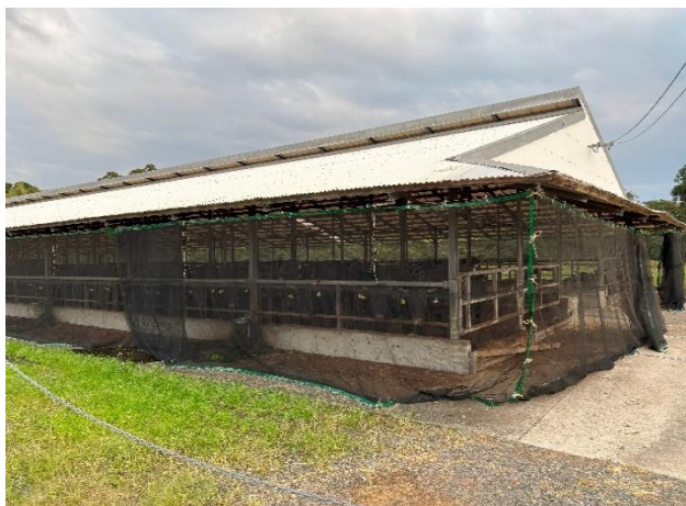
画像 9 20号舎外観
