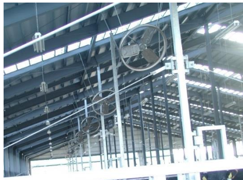
天井からの採光や 換気扇の設置
